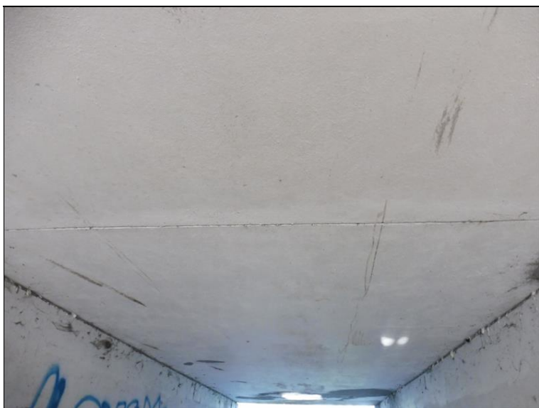
Spára v NK mezi levým a pravým mostem.
